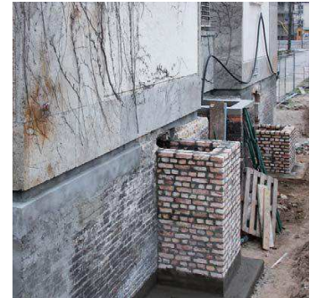
Kellermauerwerk mineralisch abgedichtet.
