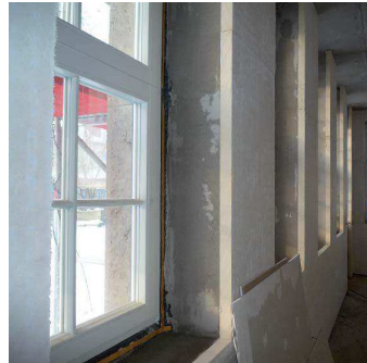
Montage der iQ-Therm Innendämmung.
